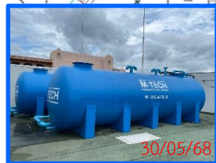
ถังเก็บน้ำชั้นดาดฟ้า ขนาดความจุ 150 ลบ.ม.
